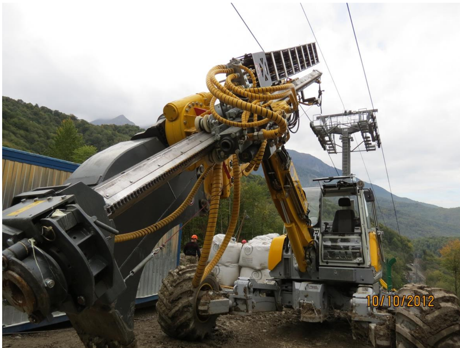
Перед началом работ по инжзащите действующей канатки
