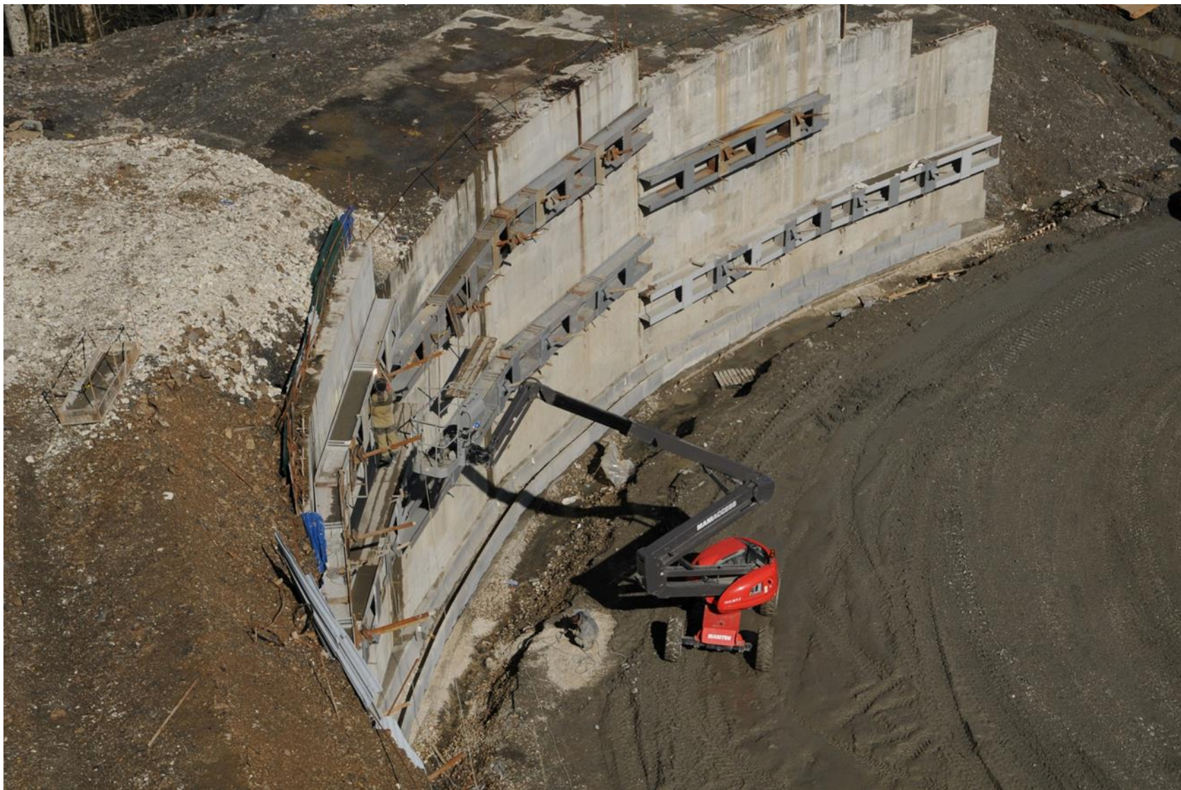
Натяжение анкеров GEOIZOL-MP через балку
