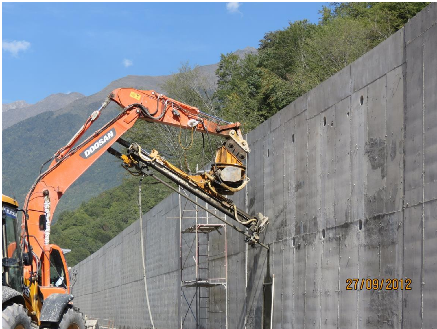
Устройство ряда анкеров на высоте до 10 метров
