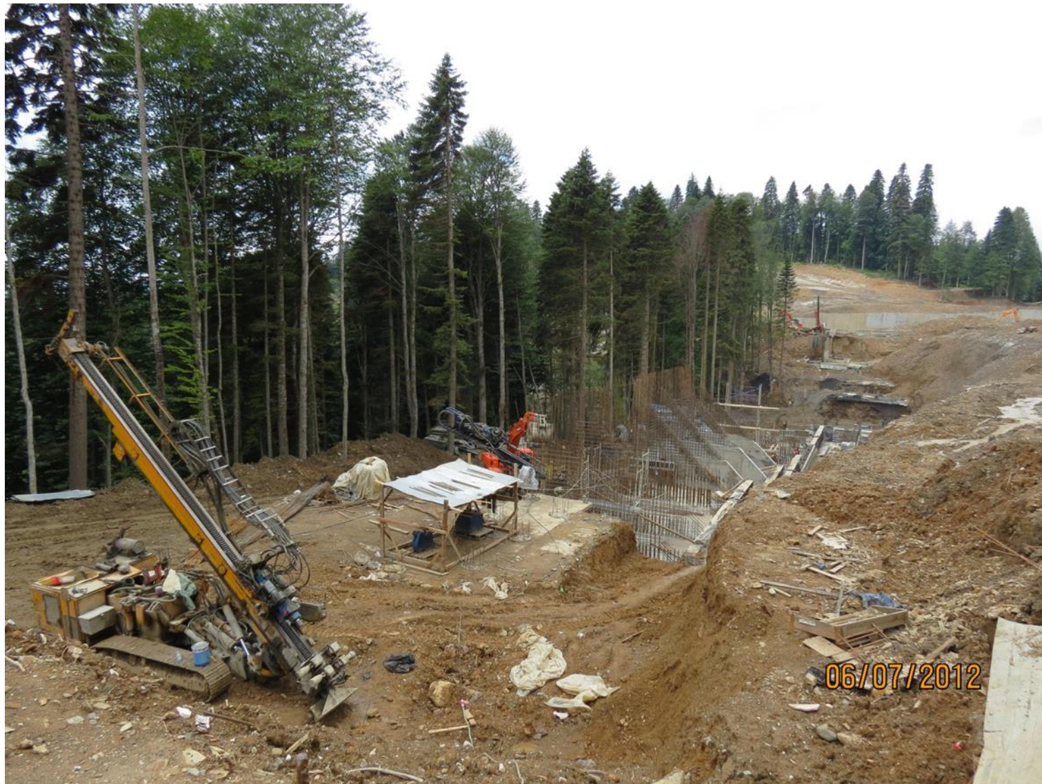
Совмещенные работы по устройству подпорной стены
