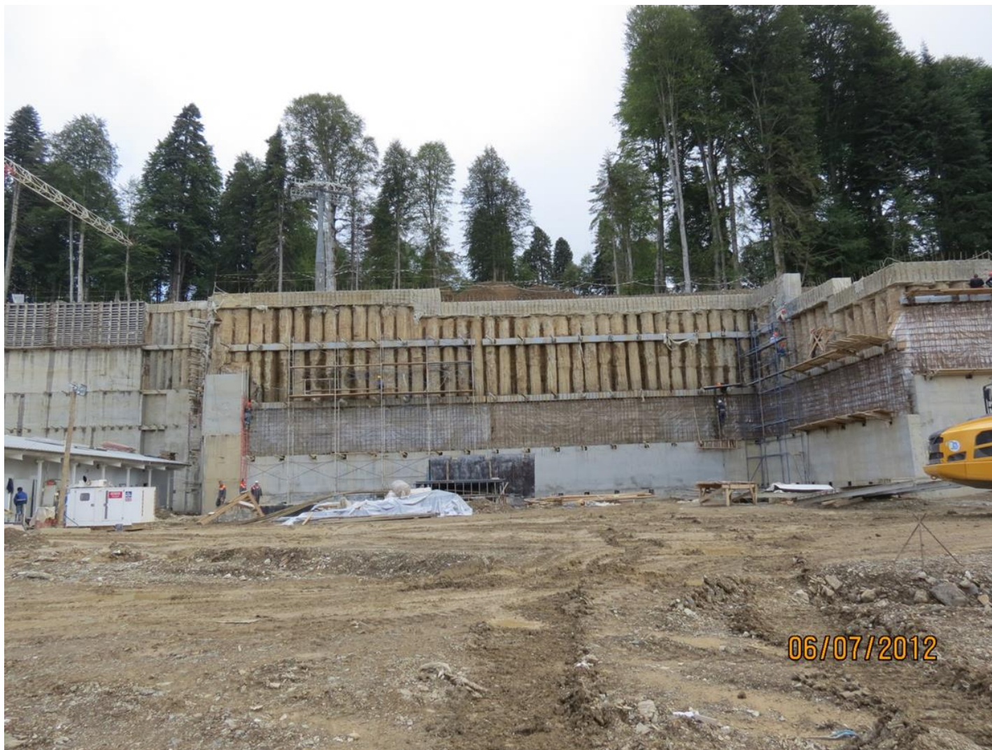
Сорокаметровые двухрядные сваи, 25-метровая прижимная стенка, пять рядов анкеров длиной 45 метров
