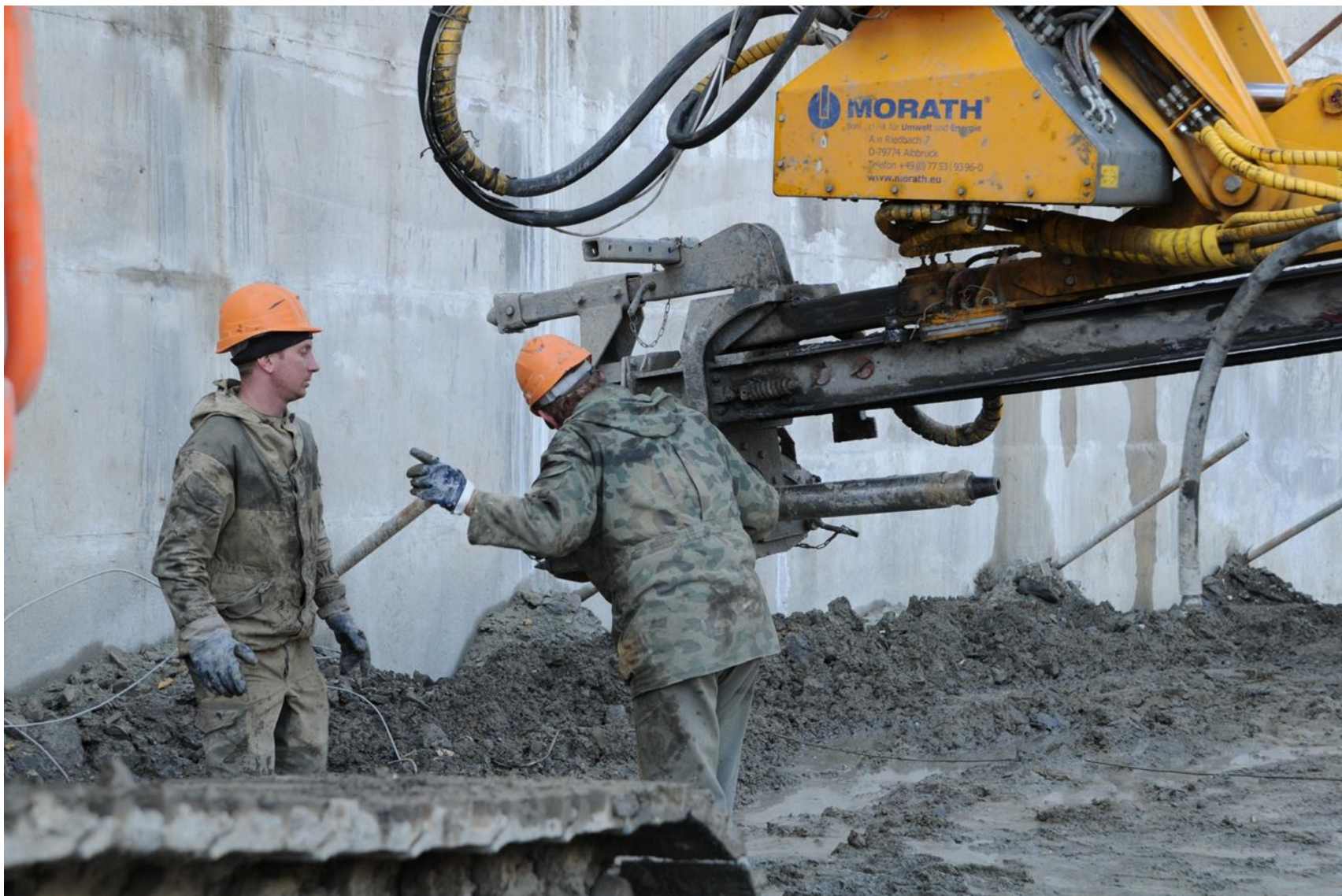
Навесное оборудование для устройства анкеров большого диаметра и длины на тяжелом экскаваторе
