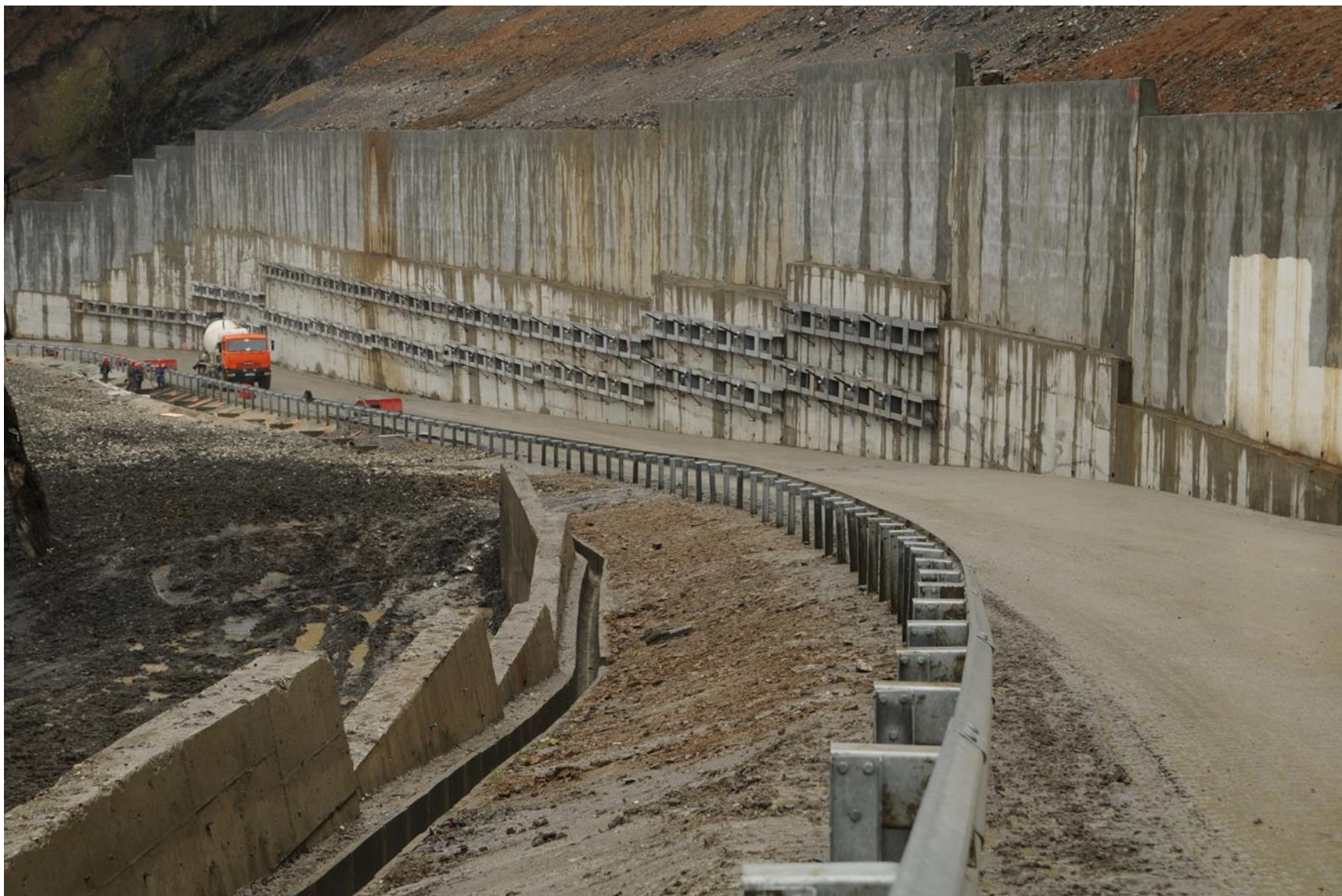
Участок дороги перед благоустройством
