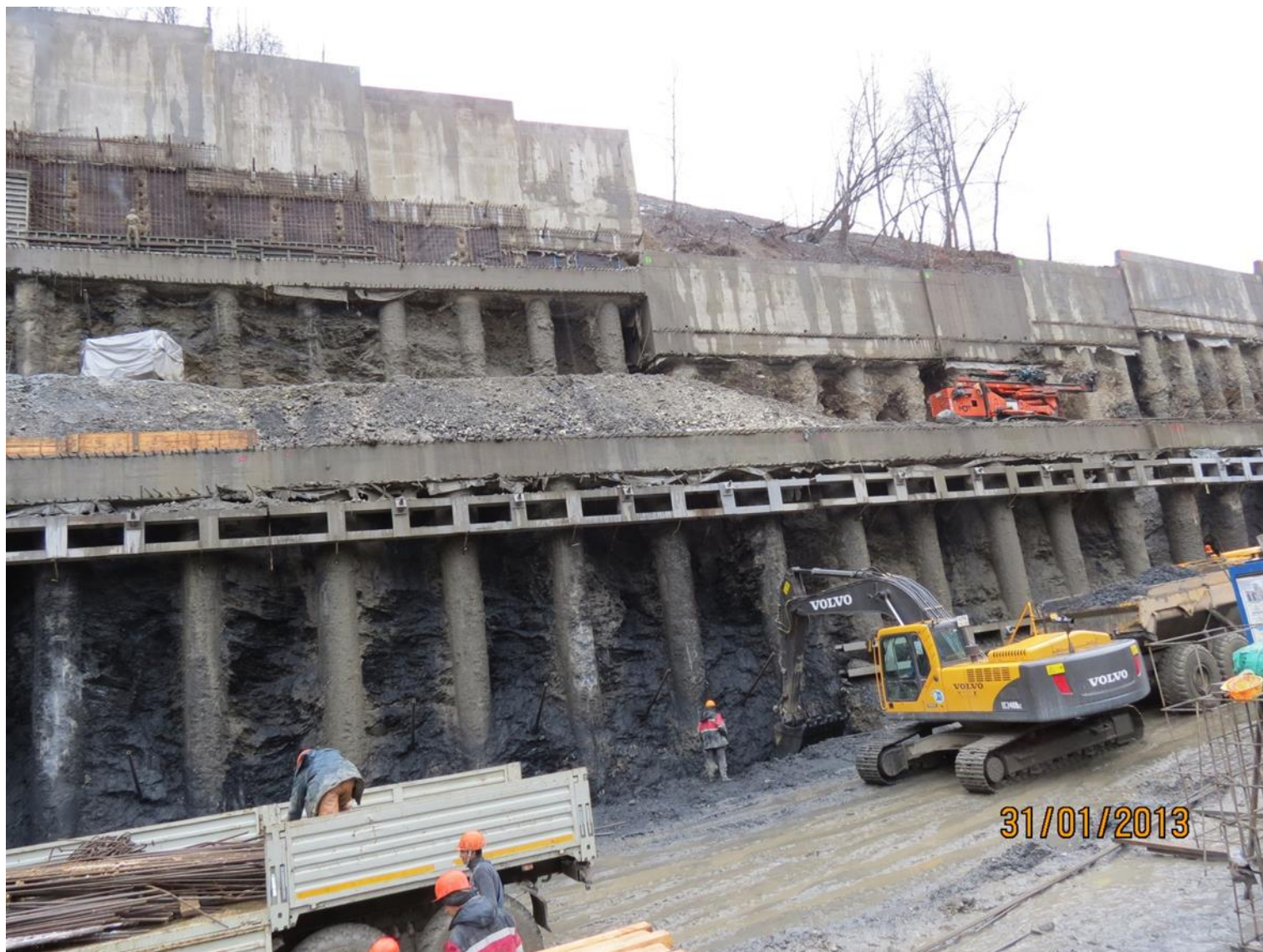
Устройство забирочных стен
