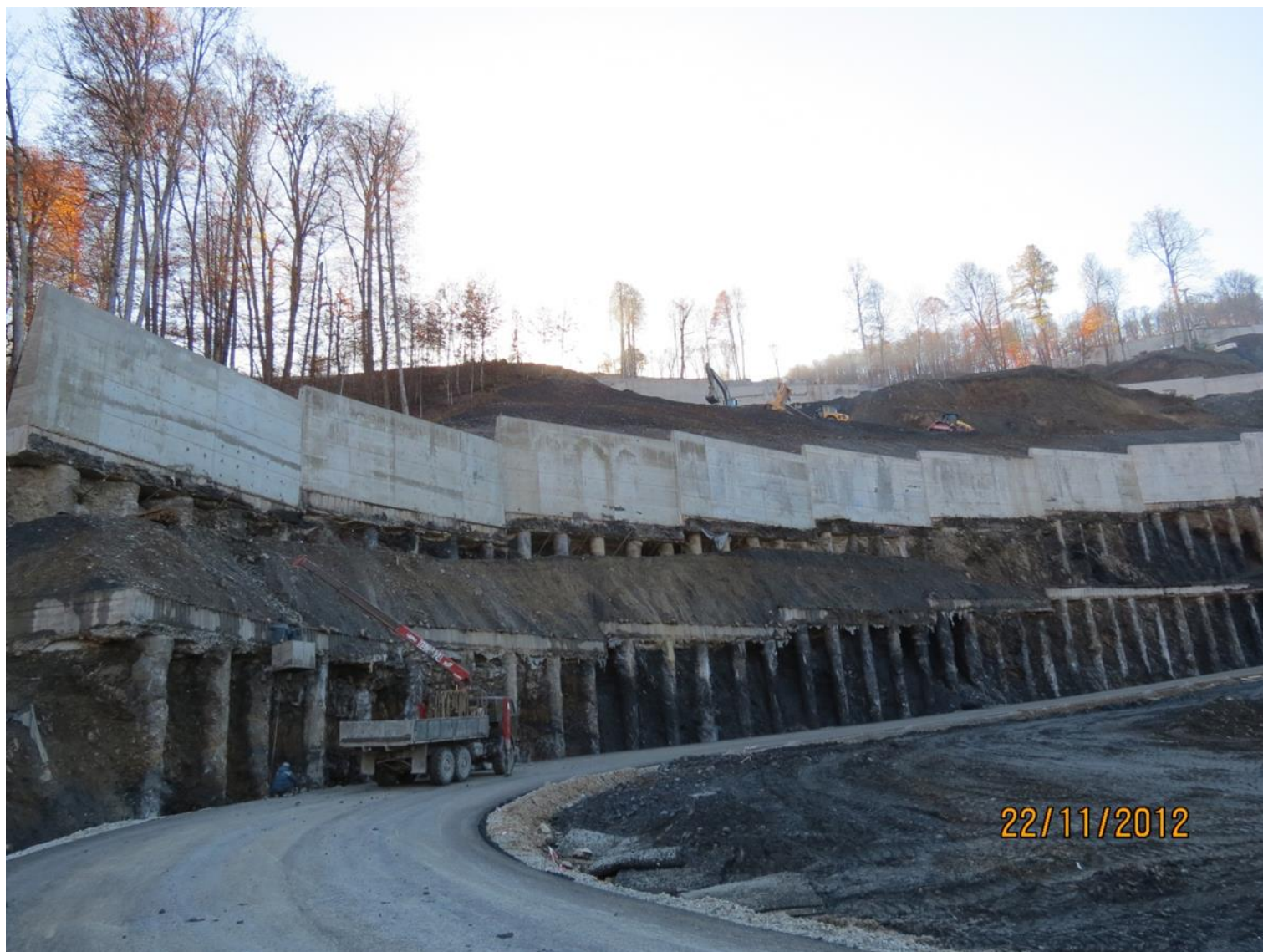
Подъездная автомобильная дорога. Две из 75 стенок.
