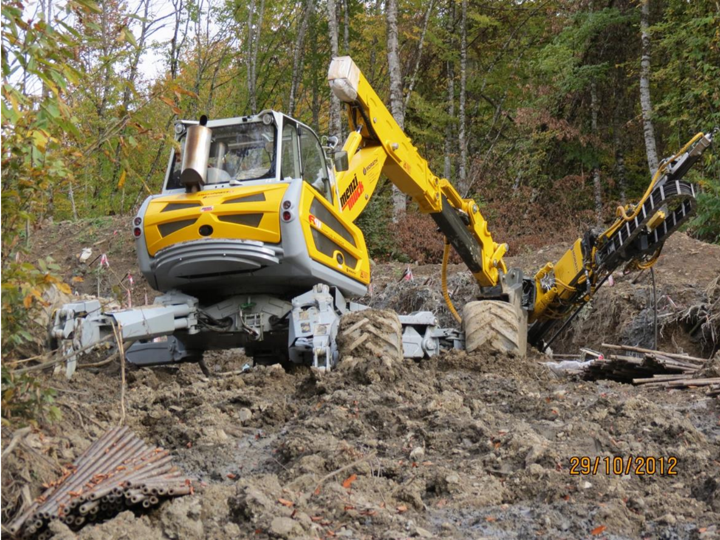
Устройство нагельных полей анкерами GEOIZOL-MP 40 мм с применением навесного оборудования на «ползающем экскаваторе» Menzi Muck
