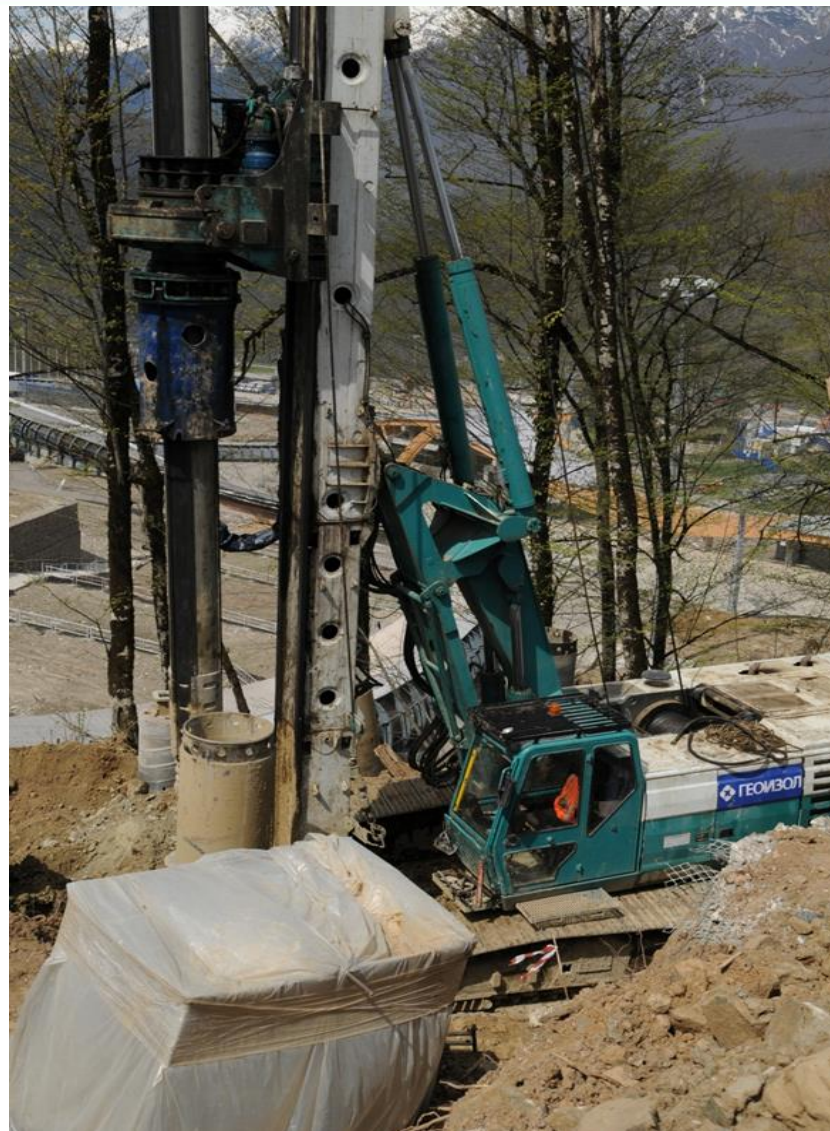
Устройство буронабивных свай. Диаметр - 1020 мм, 820 мм, длина - 40 м
