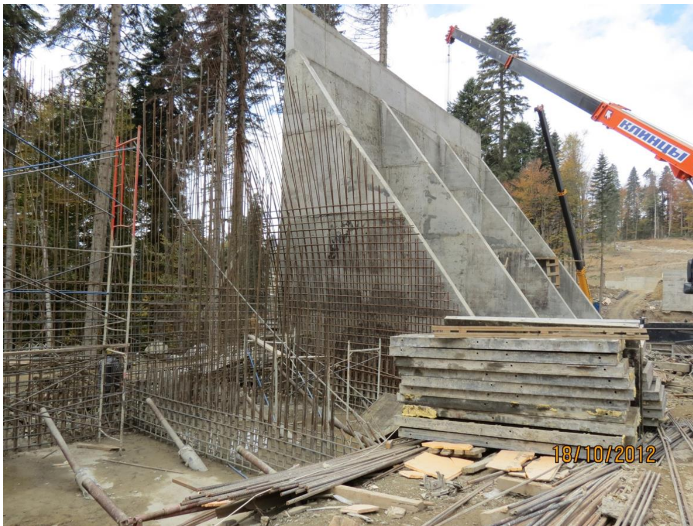
Монолитная подпорная стена высотой до 22 м на свайном основании с креплением анкерами GEOIZOL-MP 72 и 105 мм
