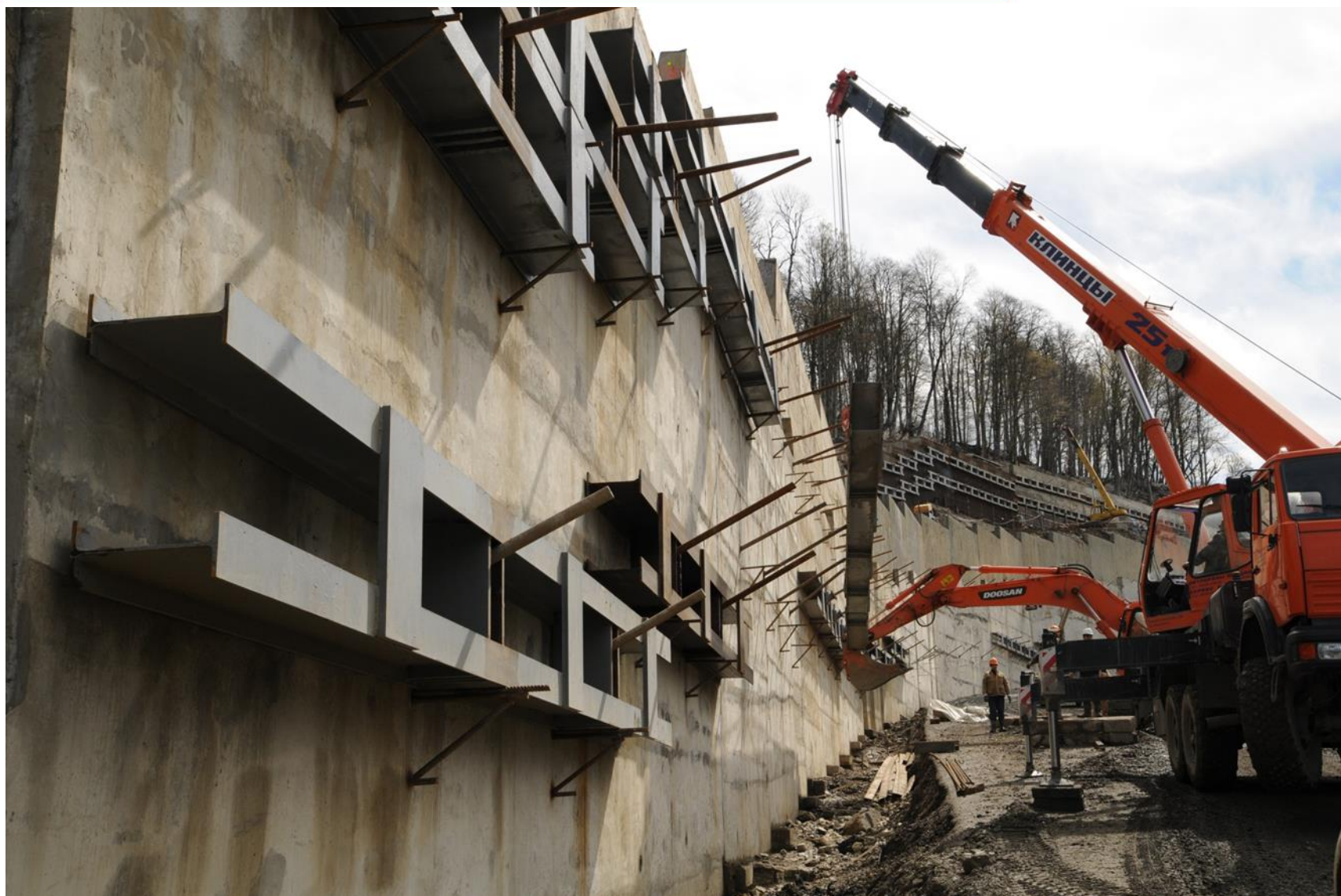
Навеска балок на подъездной дороге
