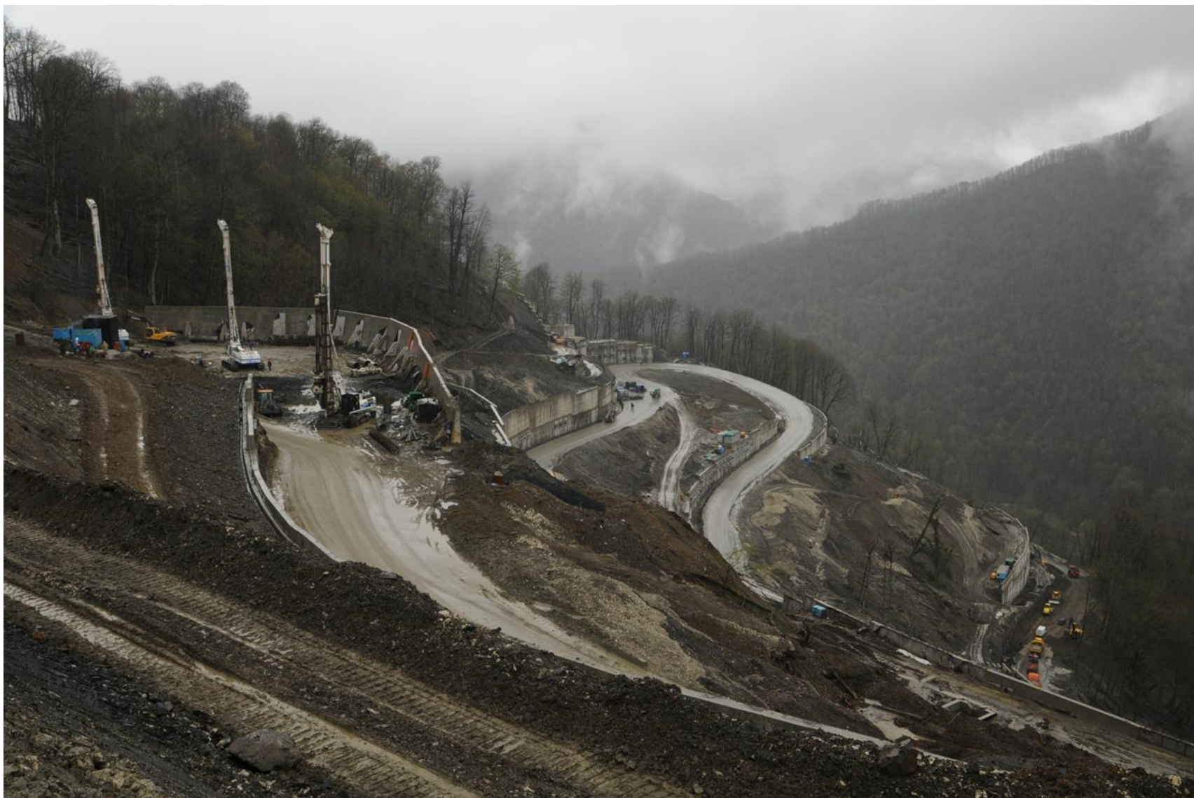
Один из участков семнадцатикилометровой подъездной дороги к стадиону.
