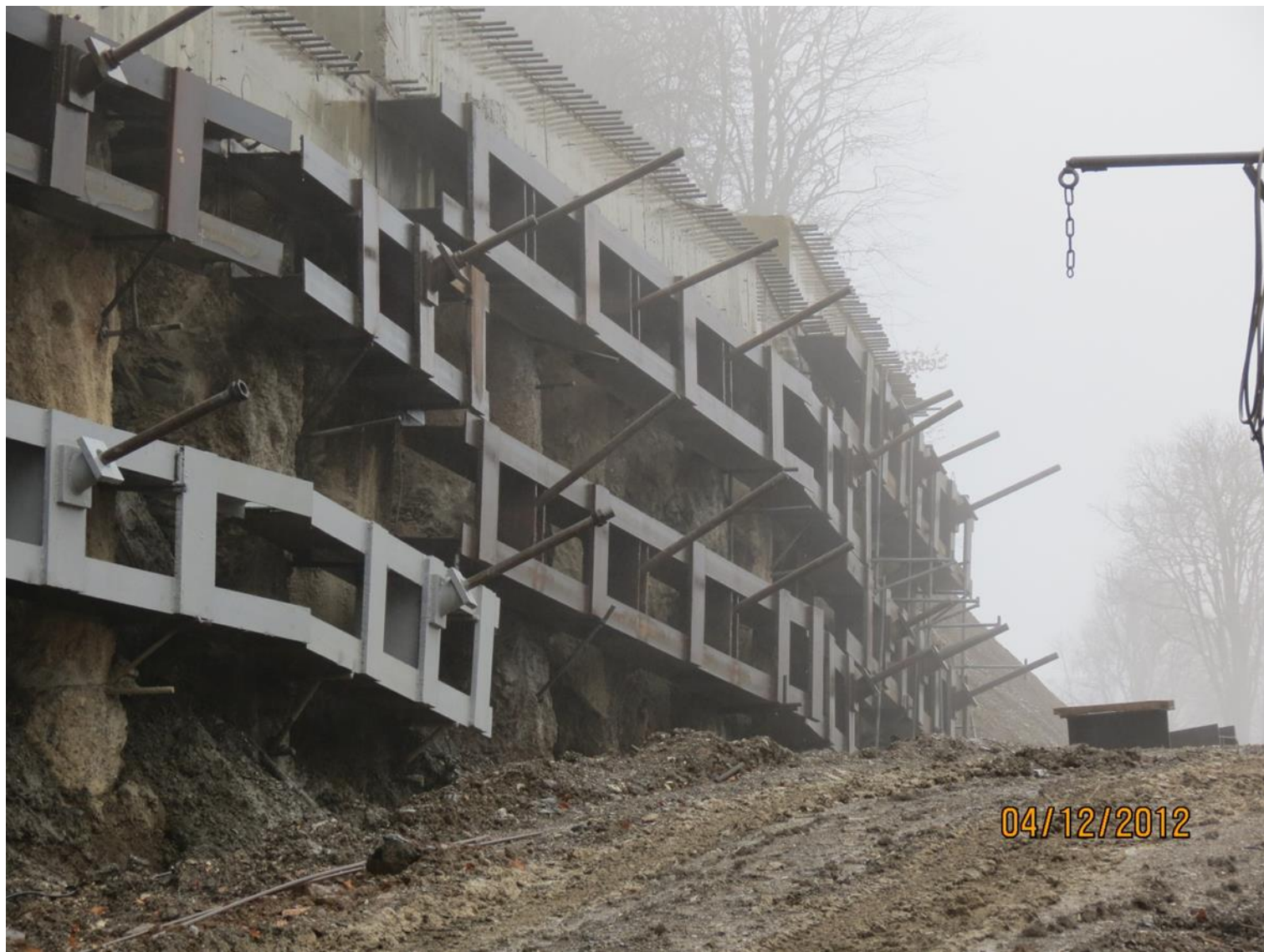
Балка со смонтированными и натянутыми анкерами
