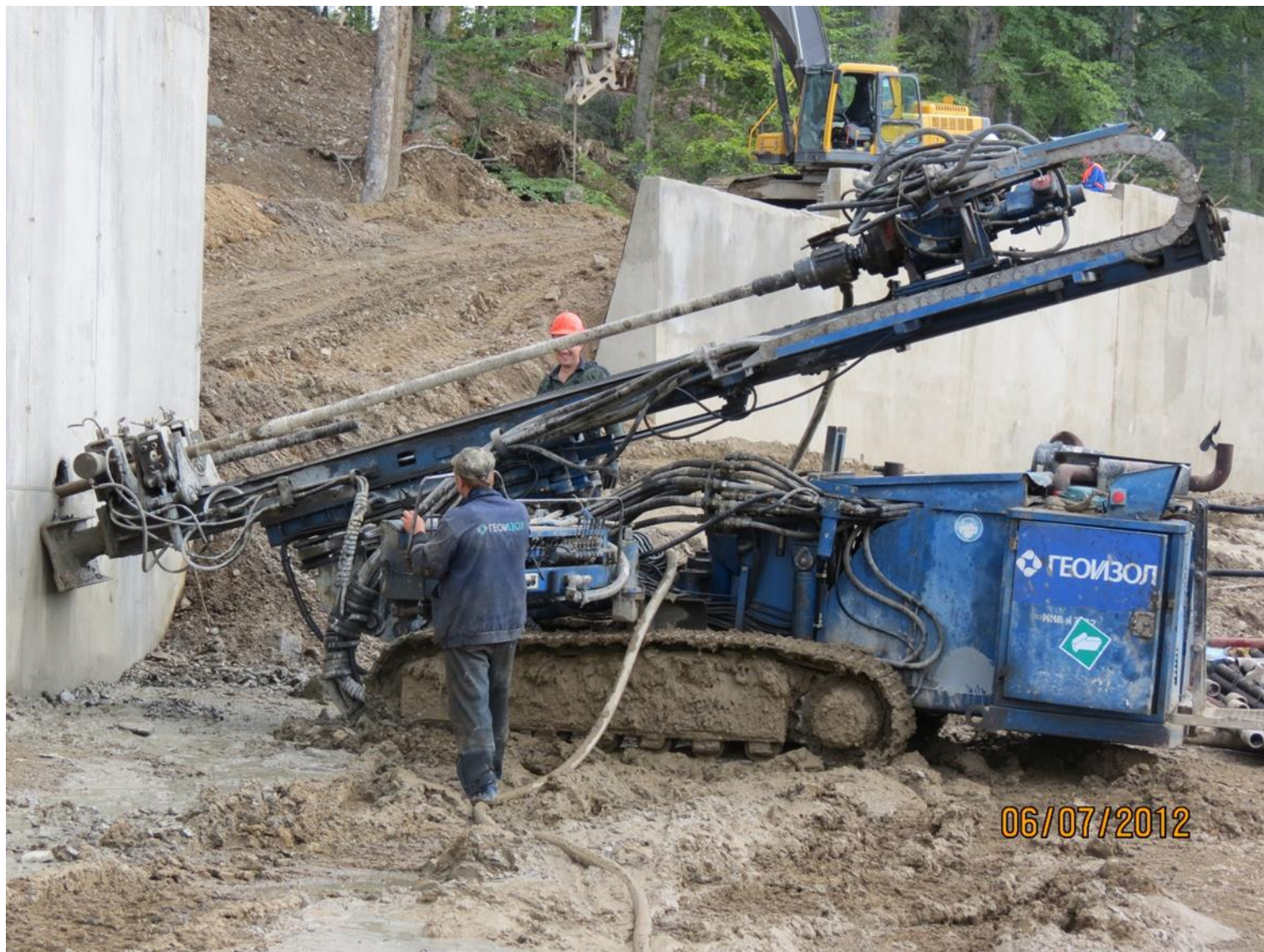
Устройство анкеров GEOIZOL-MP 72 и 105 мм тяжелыми буровыми станками
