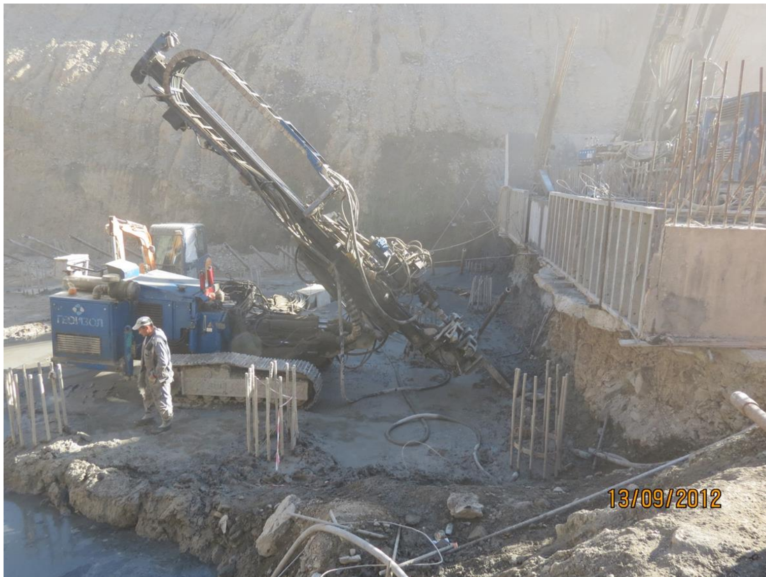
Устройство застенного ряда анкеров
